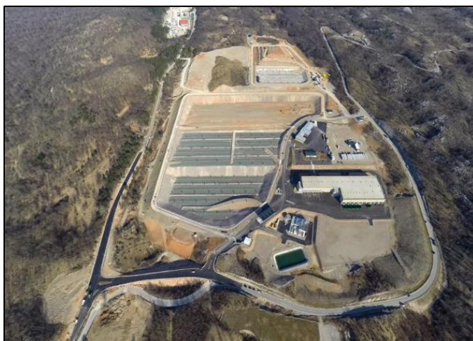
Slika 9. Postrojenje mehaničko biološke obrade u ŽCGO Marišćina (izvor: http://www.ekoplus.hr )
