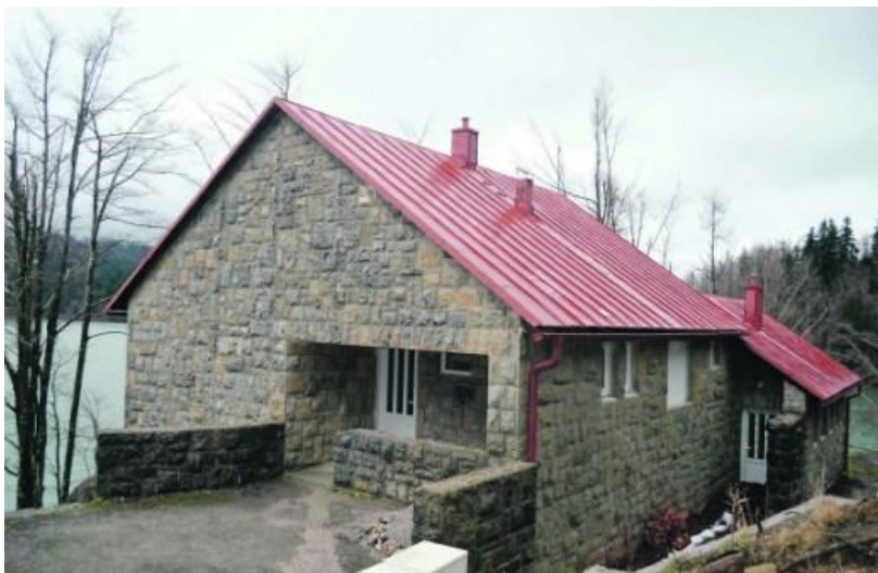
Slika 2: Tehnička kuća na brani
